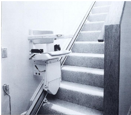
شکل ۱۷. نصب بالابر بر روی پله
