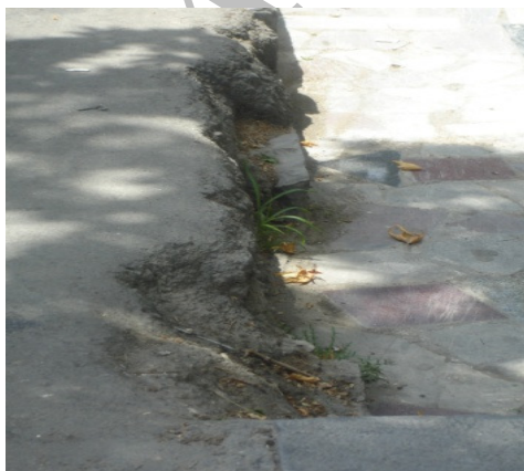
تصویر ۲: تعبیه‌نشدن جدول بین پیاده‌رو و جوی کنار آن (منبع: نگارنده ۱۳۹۰)
