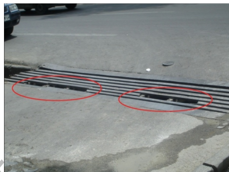
تصویر ۴: نمونه‌ای از یک پل ارتباطی ناهموار نامناسب برای عبور معلولین (منبع: نگارنده، ۱۳۹۰)
